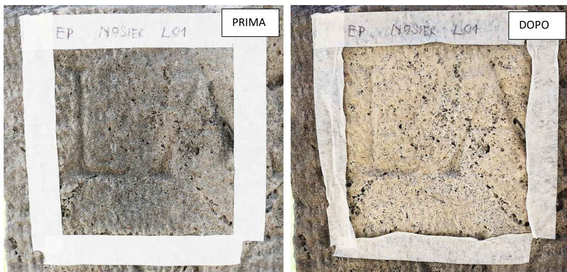
Figura 8- Tassello EP: Trattamento di decorazione architettonica con NASIER L01 per 60 minuti; a sinistra: prima del trattamento; a destra: dopo il trattamento.
