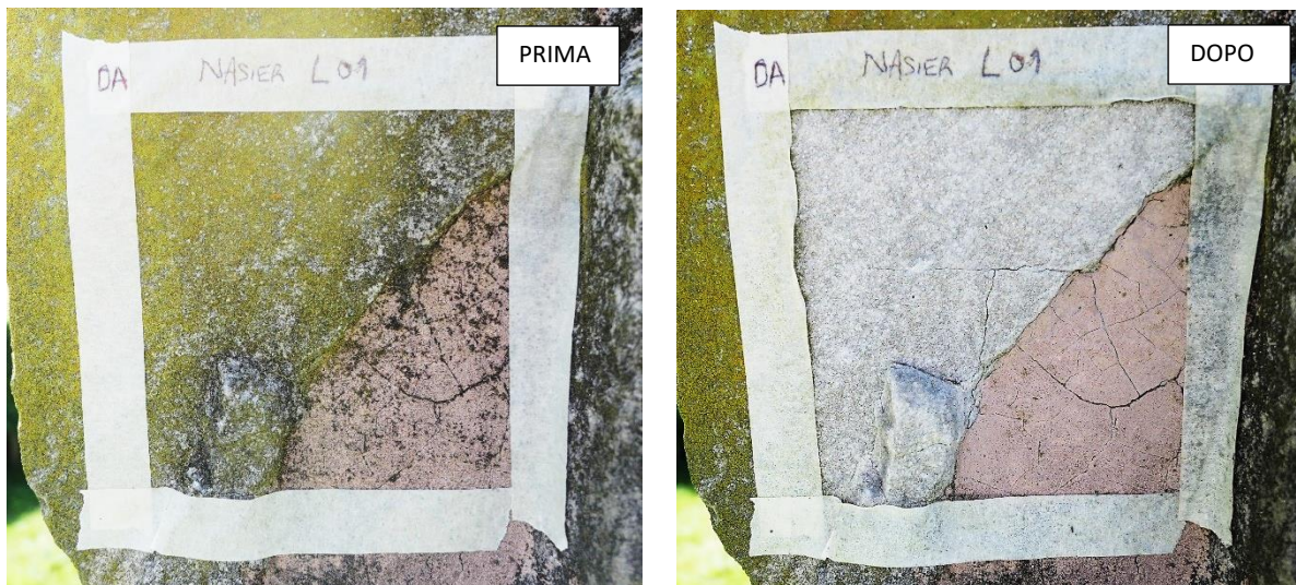
Figura 6 – Tassello DA: Trattamento di decorazione architettonica con NASIER L01 per 60 minuti; a sinistra: prima del trattamento; a destra: dopo il trattamento.
