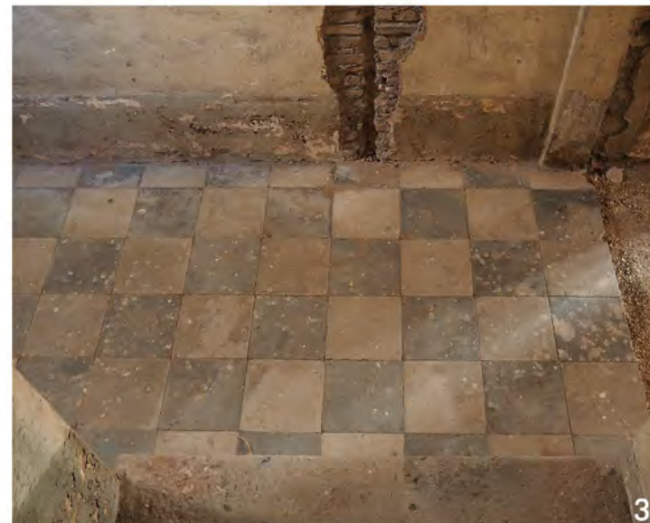
PAVIMENTAZIONE A SCACCHIERA IN CEMENTINE 25x25cm
