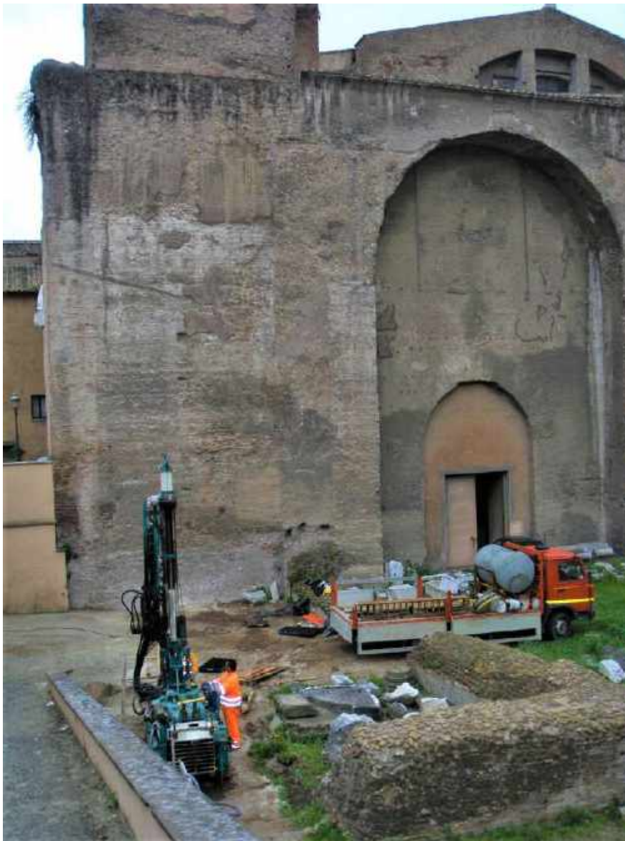
Fig. 22 – Esecuzione del sondaggio meccanico a carotaggio continuo SG4 profondo 45 metri.
