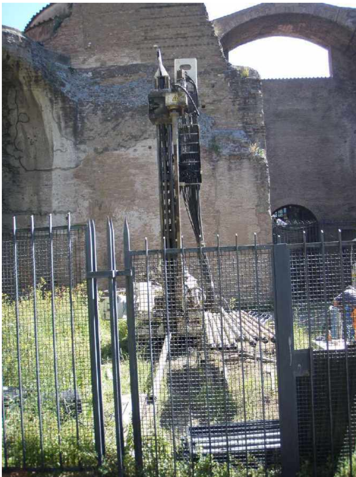
Fig. 18 – posizionamento Sonda per la esecuzione del Sondaggio meccanico a carotaggio continuo SI.
