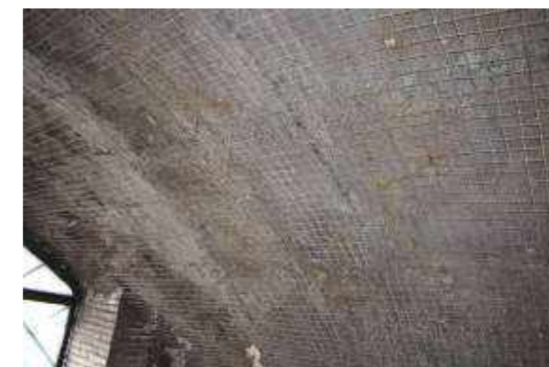
Intradosso della volta in CA
