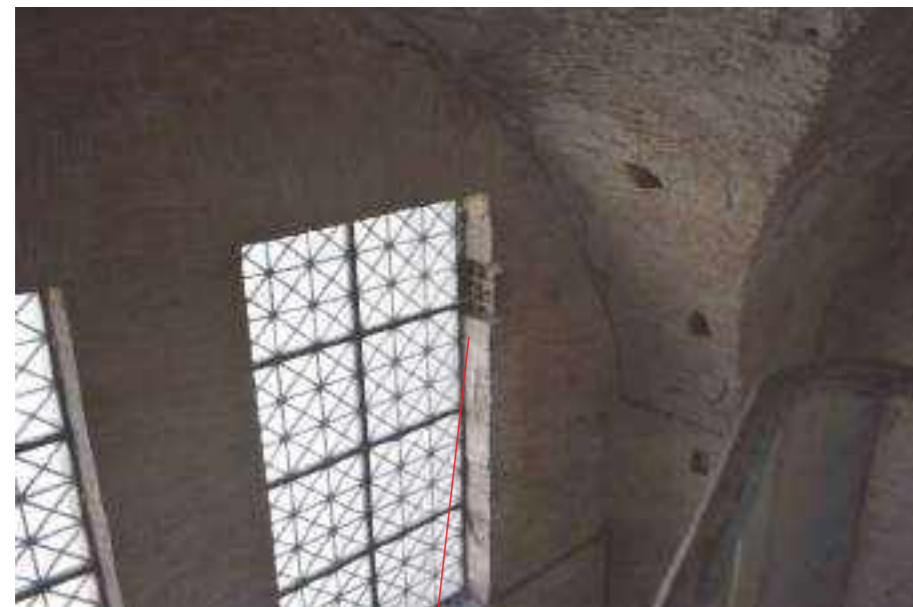
Piastra di ancoraggio a vista
