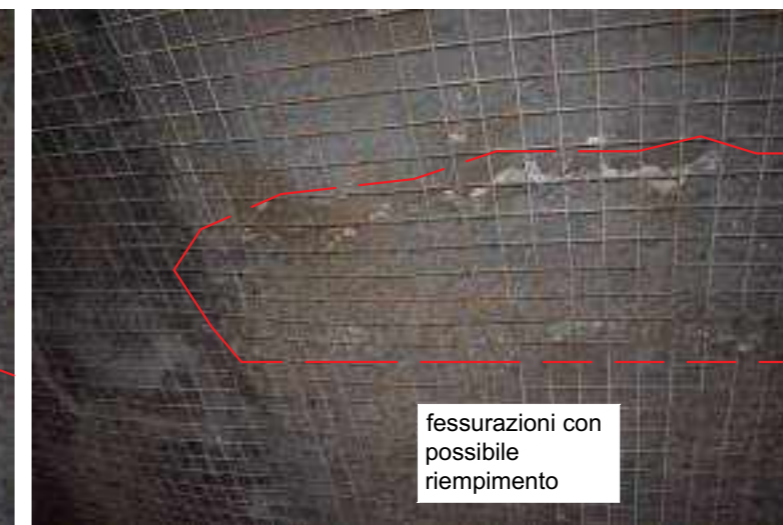
Visibili fessurazioni con possibile punto di riempimento
