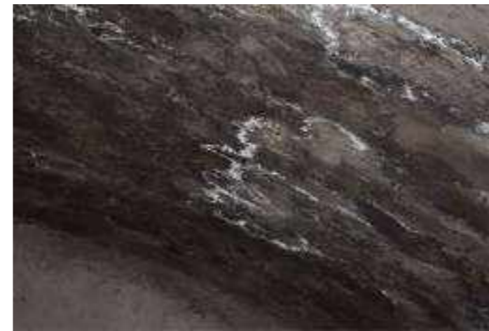
Visibili diffuse macchie di efflorescenze saline causate dalla percolazione di sali del cemento armato, dovute alle infiltrazioni nella copertura testimoniate dalle indagini videoendoscopiche e probabilmente da infiltrazioni attraverso il terrazzo.
