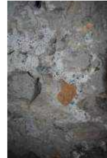
Campione prelevato A4 in corrispondenza di una zona non fissa, facilmente rimovibile, quindi a rischio caduta.
