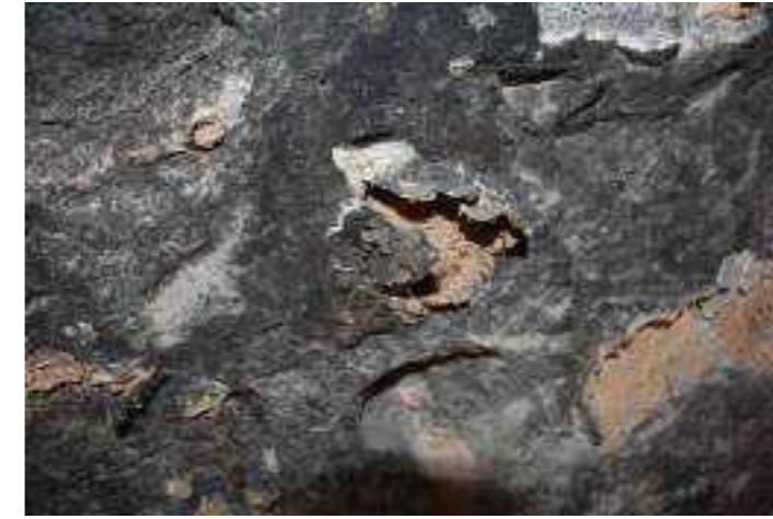
Dettaglio della volta originale con tufelli a vista a causa del degrado e intonaco in fase avanzata di esfoliazione.
