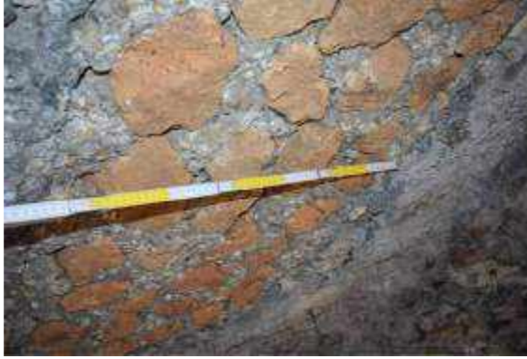
Intervento localizzato di rifacimento con tufelli e calcestruzzo moderno.
