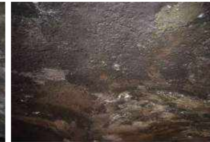
Visibili diffuse macchie di efflorescenze saline causate dalla percolazione di sali del cemento armato, dovute alle infiltrazioni nella copertura testimoniate dalle indagini videoendoscopiche e probabilmente da infiltrazioni attraverso il terrazzo.
