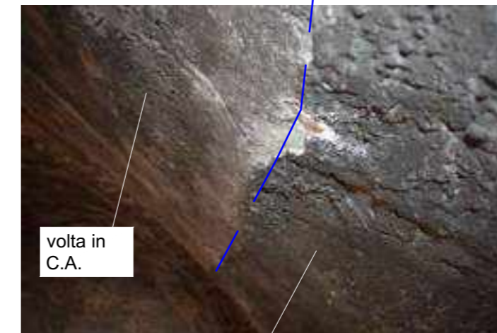
volta originale con sopra intonaco proiettato
