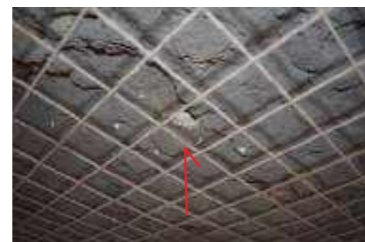
Foro esistente in cui è stata eseguita la videoendoscopia V4
