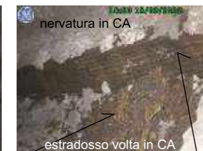
Sull'estradosso della volta presenti depositi possibile di ruggine
