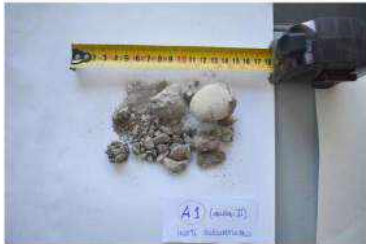
Figura 4.1.2.5 Calcestruzzo prelevato all'intradosso della volta dell'aula II con il campione A1
