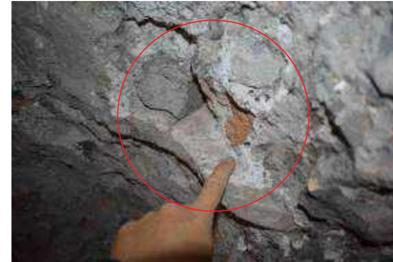
Campione prelevato A4 in corrispondenza di una zona non fissa, facilmente rimovibile, quindi a rischio caduta.
