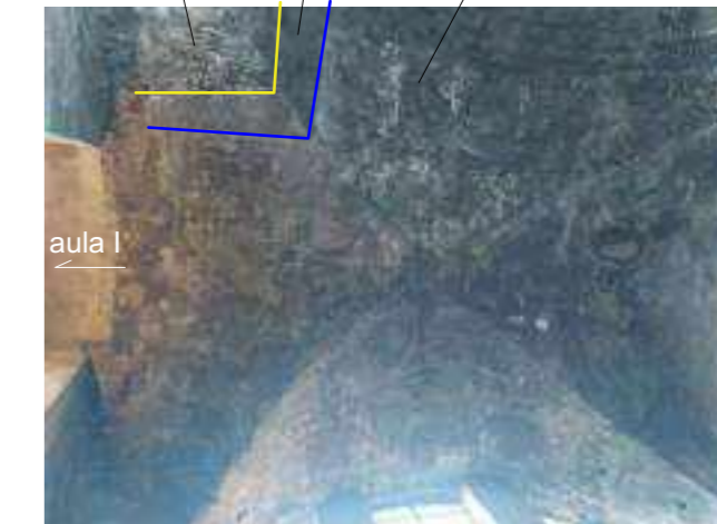
volta originale volta originale con sopra intonaco proiettato volta in CA
