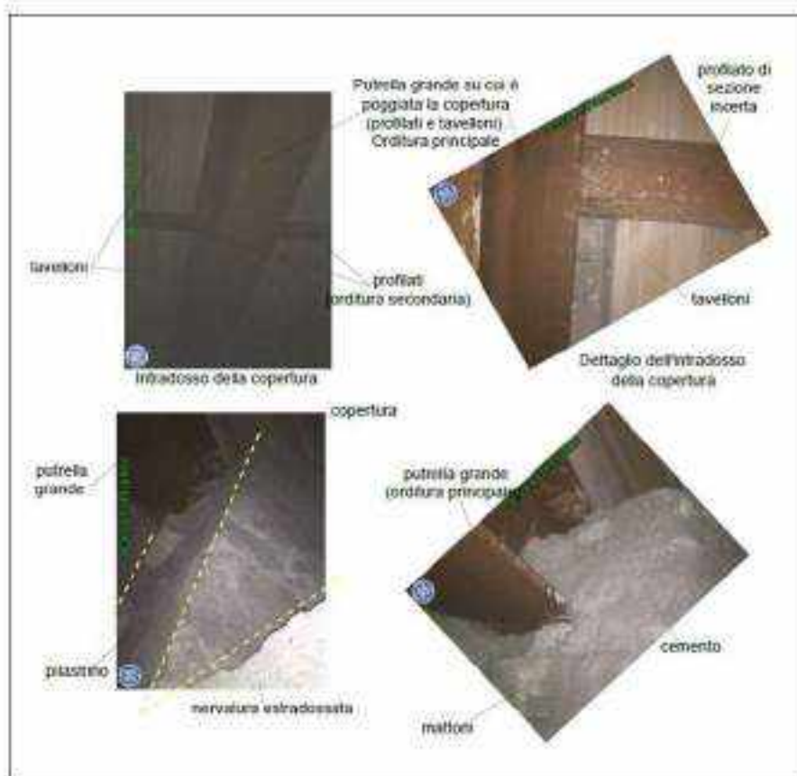
Figura 4.1.3.1 Foto di dettaglio del pilastro in C.A. e della copertura in putrelle e tavelloni
