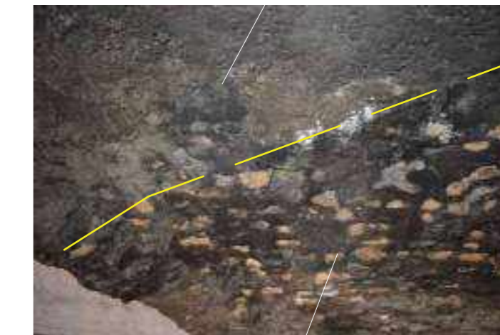
volta originale con tuffelli a vista a causa del degrado
