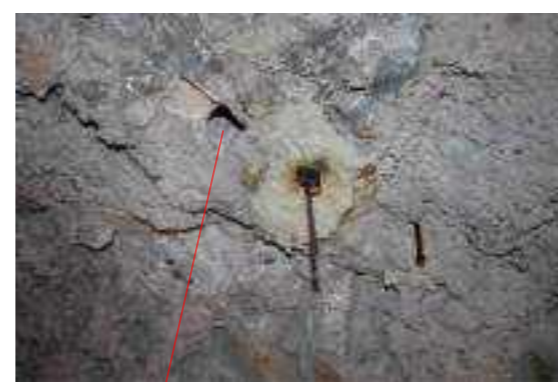
foro esistente in cui è stata eseguita la videoendoscopia V2
