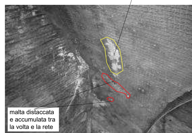
La malta è soggetta a distacchi. Nelle foto sopra riportate sono visibili le zone di distacco della malta, che in parte è già caduta e trattenuta dalla rete metallica di intradosso.
