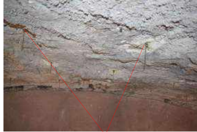
Iniezioni armate con tondini Ø10 disposti con interasse di 60x60cm.
