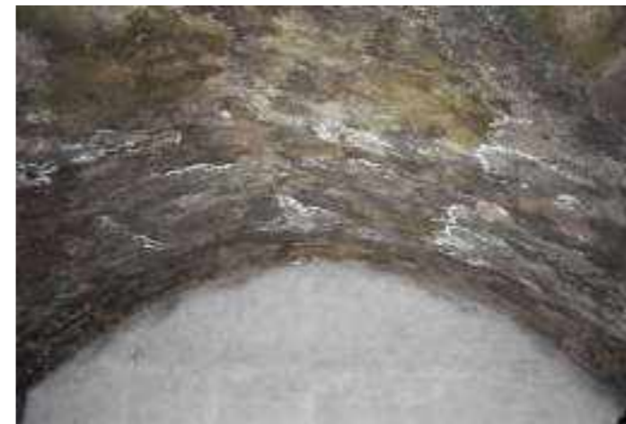
Visibili diffuse macchie di efflorescenze saline causate dalla percolazione di sali del cemento armato, dovute alle infiltrazioni nella copertura testimoniate dalle indagini videoendoscopiche e probabilmente da infiltrazioni attraverso il terrazzo.
