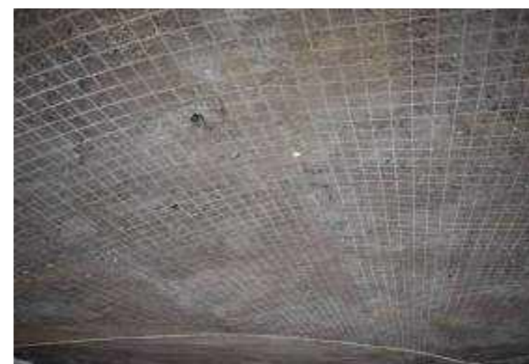
Intradosso della volta in CA
