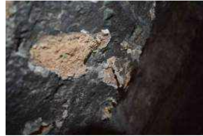
Dettaglio della volta originale con tufelli a vista a causa del degrado e intonaco in fase avanzata di esfoliazione.
