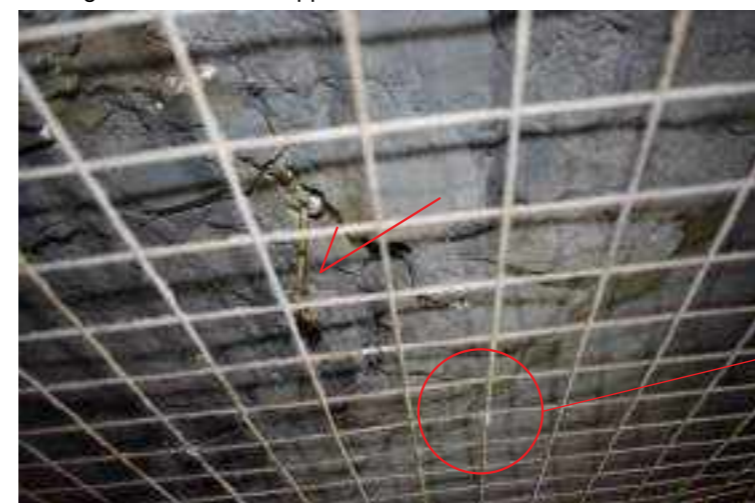
Dettaglio del sistema di appensione della rete metallica
