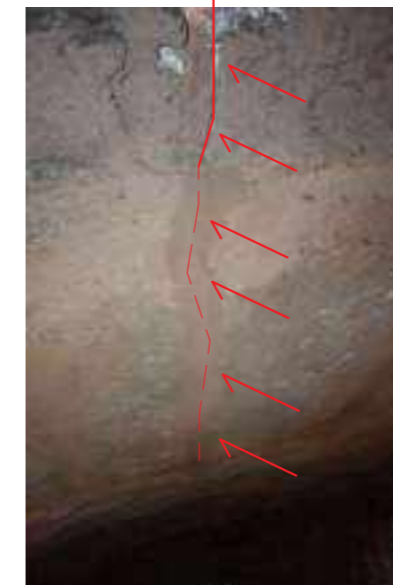
Visibile frattura in parte risarcita e in parte aperta in corrispondenza dell'arcone.
