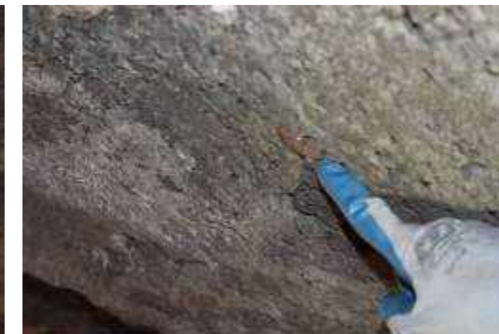
Visibili armature scoperte e ossidate ed effetti del calcestruzzo mal vibrato (vespai)
