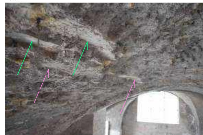
Visibili laterizi sull'intradosso della volta disposti quasi in foglio (freccia verde) e impronte di laterizi staccati (freccia rosa)
