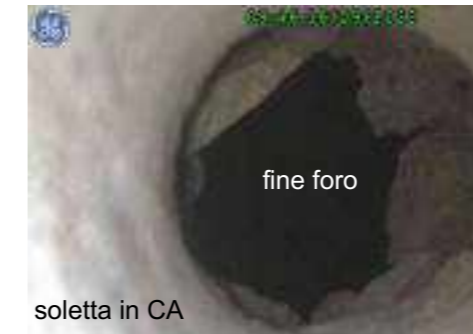
Foto all'interno del foro realizzato nella soletta in CA di 5cm di spessore.
