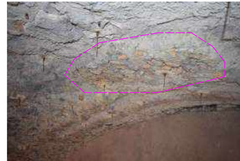
Visibile intervento con pezzi di mattoni/tuffelli
