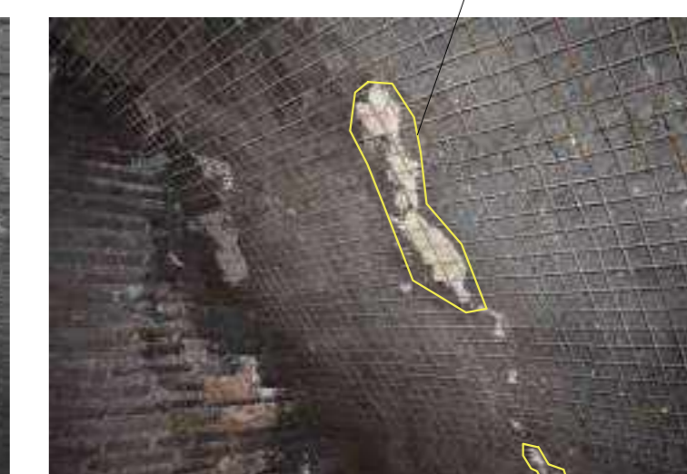
La malta è soggetta a distacchi. Nelle foto sopra riportate sono visibili le zone di distacco della malta, che in parte è già caduta e trattenuta dalla rete metallica di intradosso.
