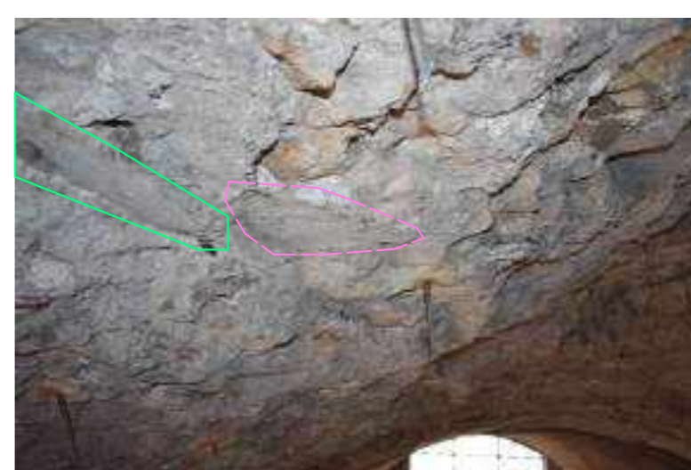
Visibili laterizi sull'intradosso della volta disposti quasi in foglio (verde) e impronte di laterizi staccati (rosa)
