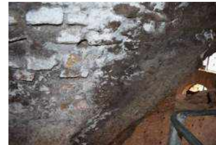
Volta originale priva di intonaco con manifestazione di efflorescenze saline
