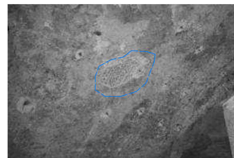
Dettaglio del possibile intonaco originale
