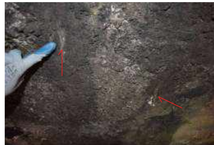
Visibili armature scoperte e ossidate ed effetti del calcestruzzo mal vibrato (vespai)
