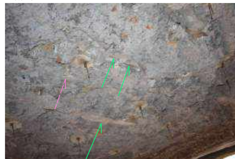
Visibili laterizi sull'intradosso della volta disposti quasi in foglio (freccia verde) e impronte di laterizi staccati (freccia rosa)
