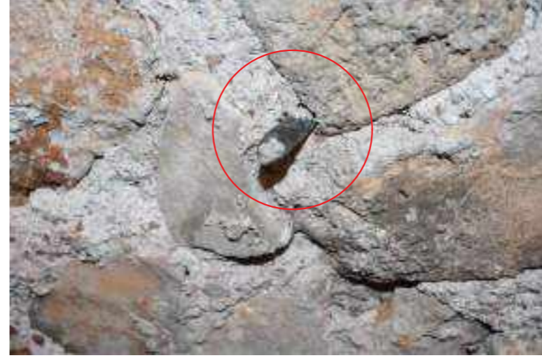
Dettaglio della cannula per l'iniezione di malta
