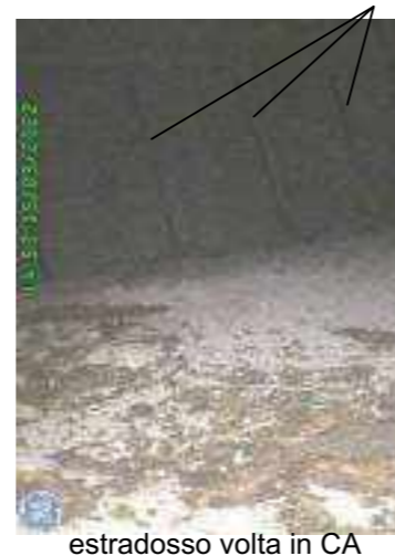
nervatura in CA con visibili staffe scoperte
