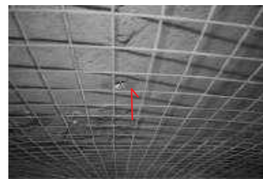
Foro esistente in cui è stata eseguita la videoendoscopia V5
