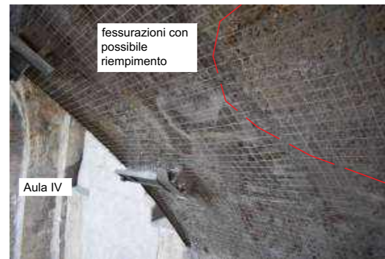
Visibili fessurazioni con possibile punto di riempimento
