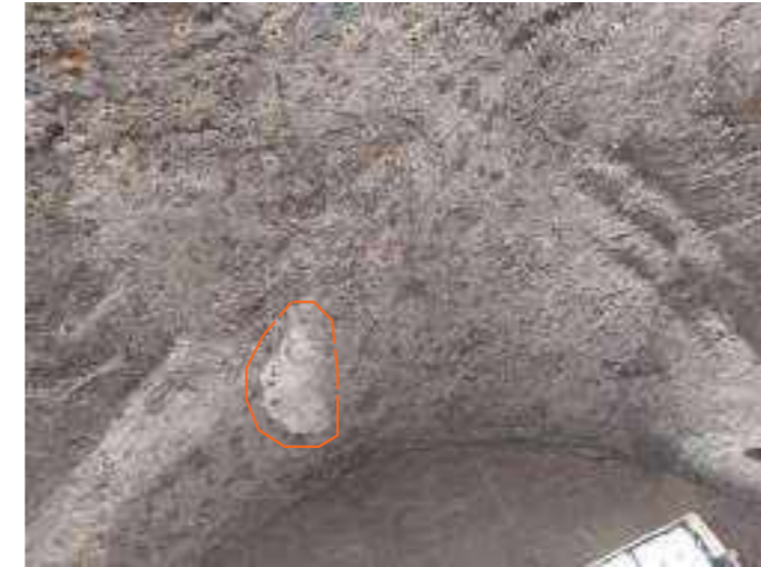
Zona diversa dal tipico aspetto dell'intradosso della volta identificabile come possibile intervento localizzato di ripresa della muratura.
