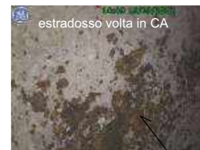
Sull'estradosso della volta presenti depositi possibile di ruggine
