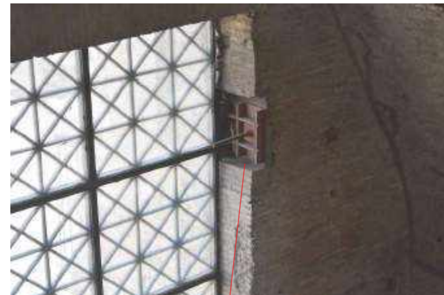
Piastra di ancoraggio a vista
