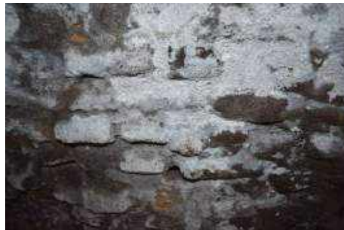
Volta originale priva di intonaco con manifestazione di efflorescenze saline
