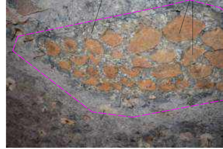
Intervento localizzato di rifacimento con tufelli e calcestruzzo moderno.
