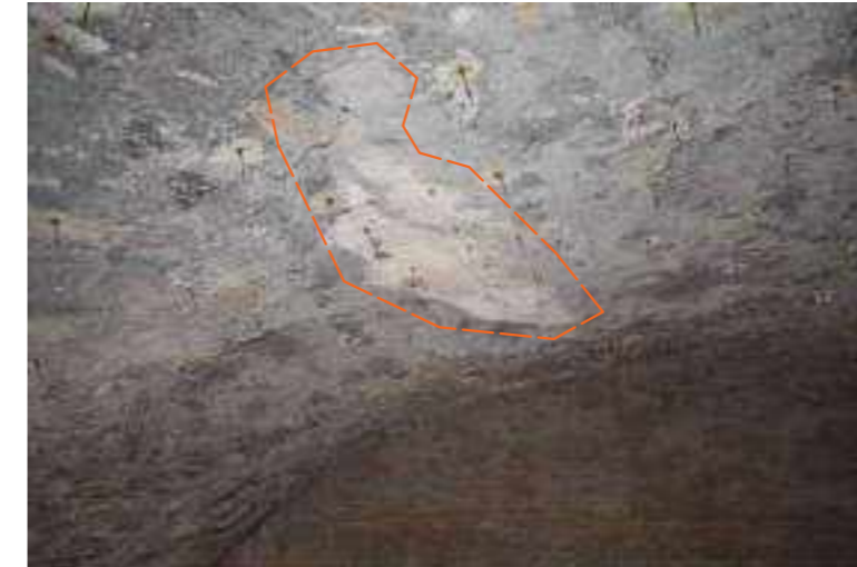
Zona diversa dal tipico aspetto dell'intradosso della volta identificabile come possibile intervento localizzato di ripresa della muratura.
