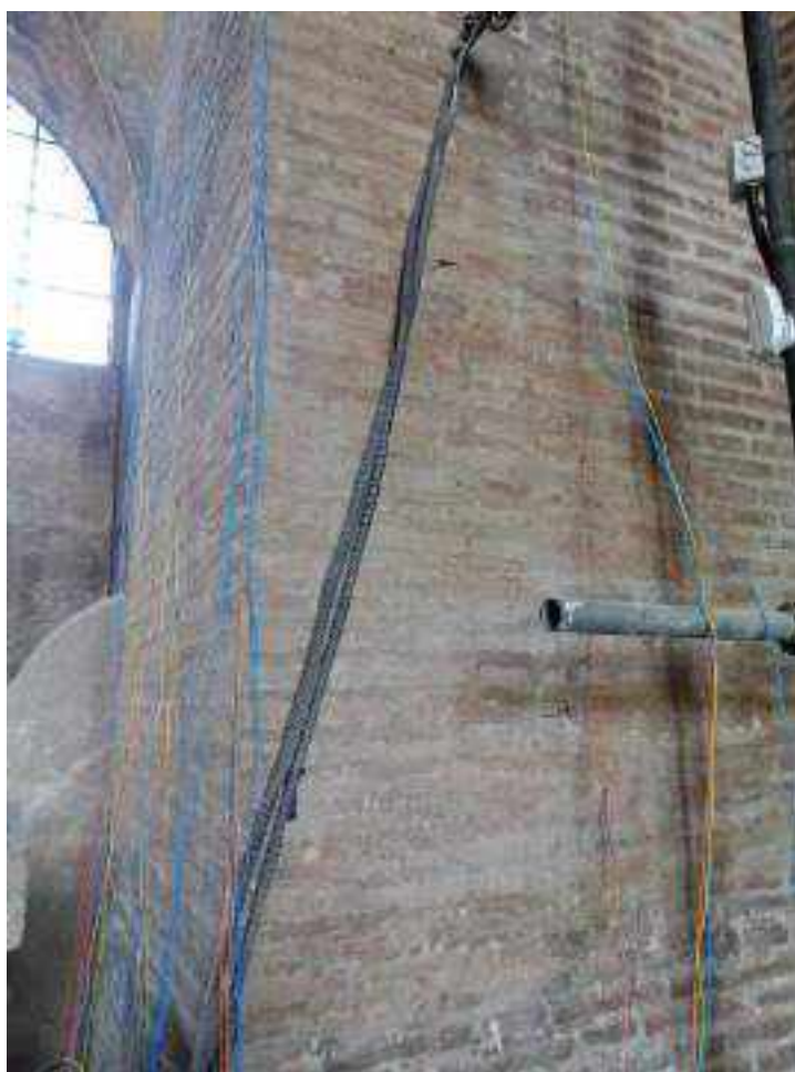
Figura 3.3.1.6 – Collegamento di fili elettrici ai chiodi per arrivare ai cavi multiconduttori
