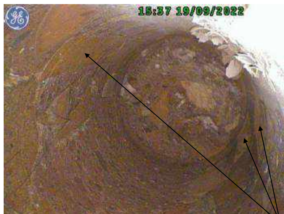
Foto 21 scattata a 200 cm dalla parete esterna laterizio
