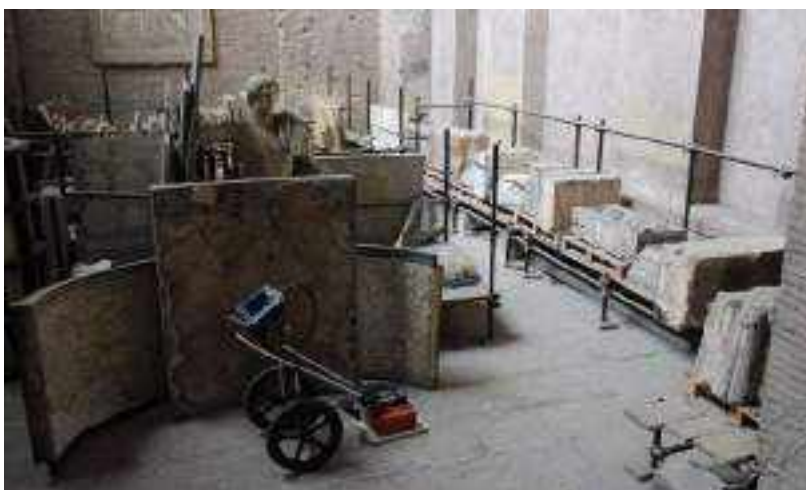
Figura 2.1.1.1. – Acquisizione con antenna radar da 400 MHz.
