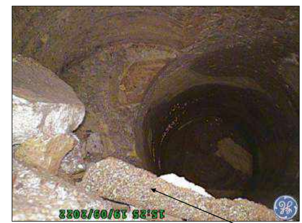
Foto 16 scattata a 150 cm dalla parete esterna Assenza di malta, zona di disgregazione
