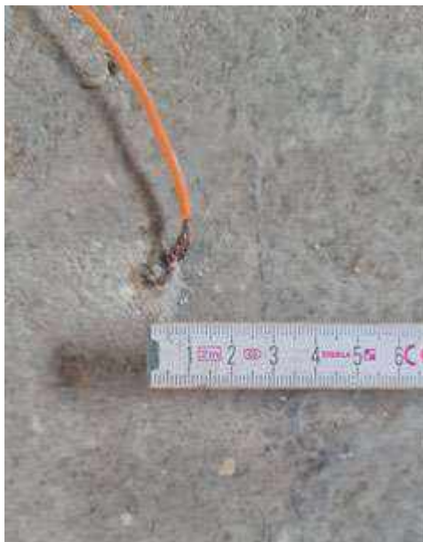
Figura 2.2.1.2.: Dettaglio della grandezza dei chiodi usati all'interno delle Aule
