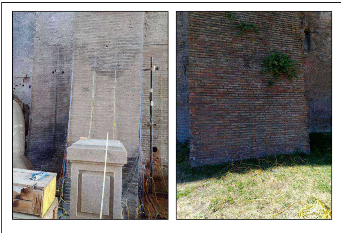
Figura 3.3.1.1 – Fase di acquisizione sul Pilastro 2.
