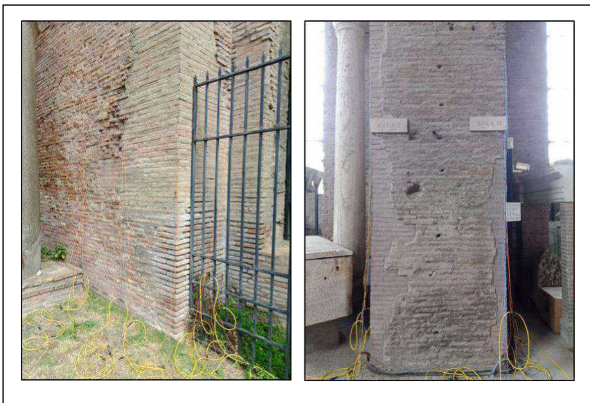
Figura 3.3.1.2 – Fase di acquisizione sul Pilastro 4.
