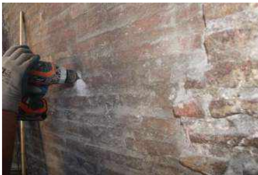
Figura 3.3.1.4 – Realizzazione dei microfori nel paramento
