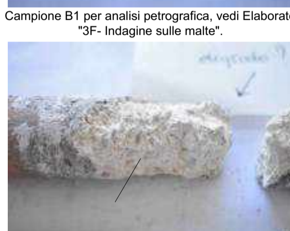
Campione B1 prelevato corrispondenza di una porzione con possibile presenza di malta degradata.
