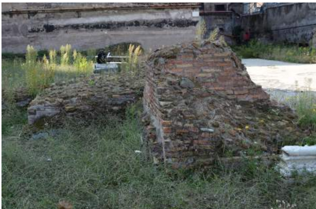
Fig. 20 - Resti delle murature del settore nord-ovest delle Terme di Diocleziano. Vista della sezione interna di un pilastro. (Rilievo fotografico Settembre 2019)
